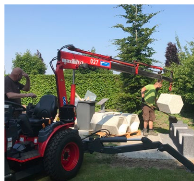
Stellen en montage
